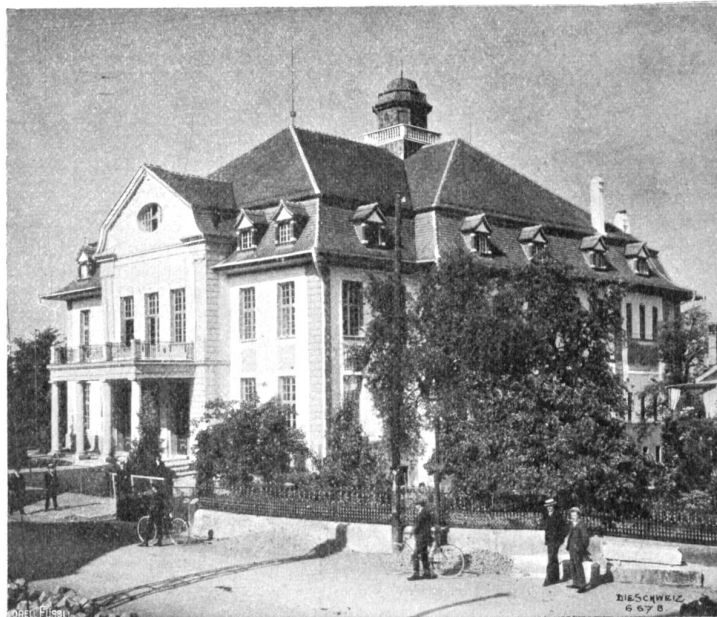
Das neue Theater in Zug. Phot. Ed. Buchmann, Zürich.
