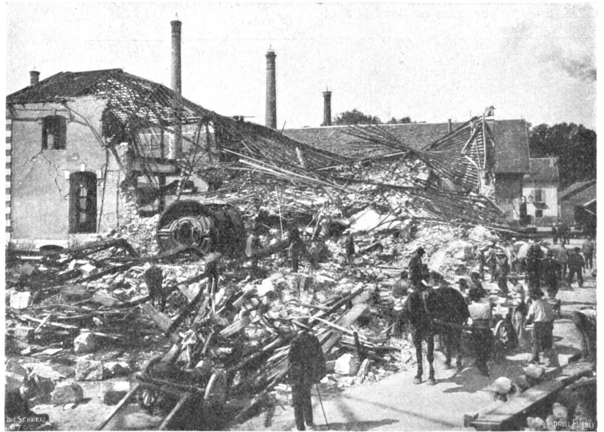
Explosion in Genf. Die zerstörten Laboratorien und Gasreinigungsgebäude. In der Mitte der Standart-Wäscheapparat, die mutmaßliche Epplionsstelle. Phot. Anton Krenn, Zürich.
