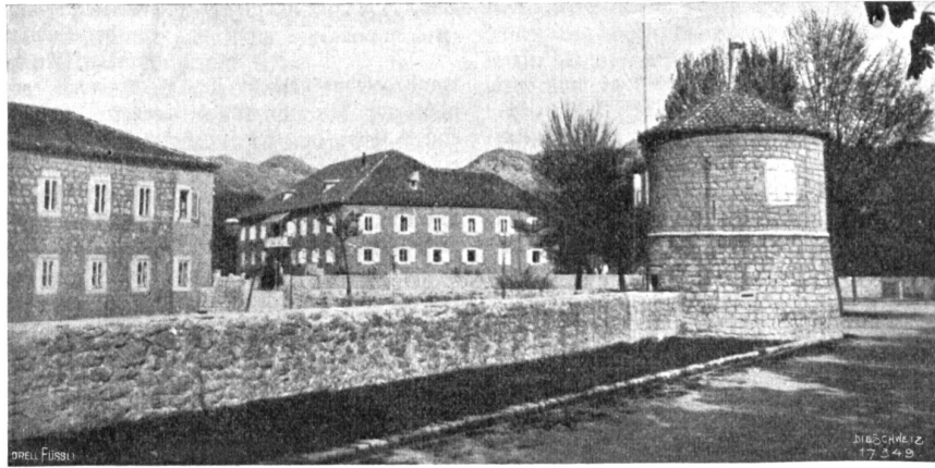
Hus Montenegro. Das alte und das neue Fürstenpalais in Cetinje.
