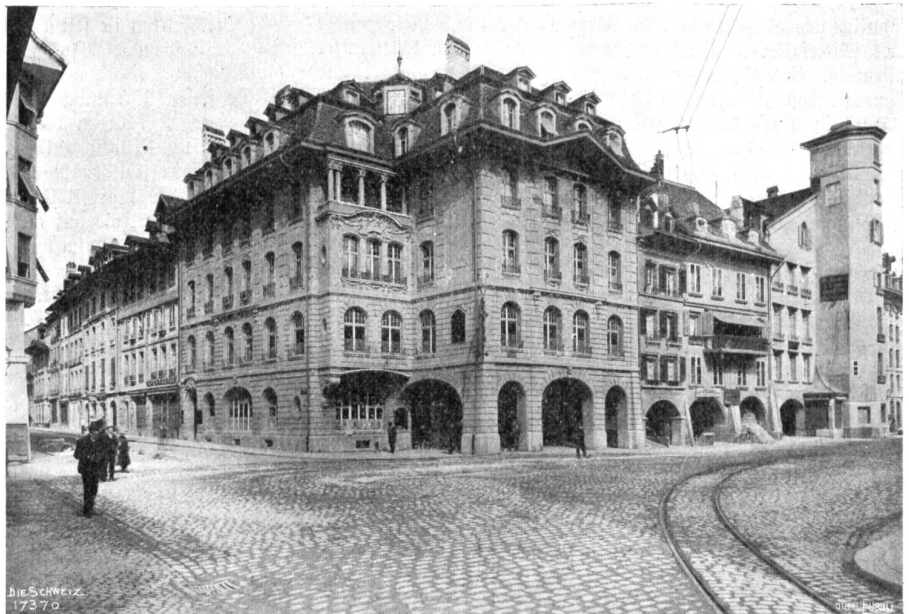
Neue Berner Baukunst. Restaurant Zytglogge. Architekt: Eduard Joos, Bern.
