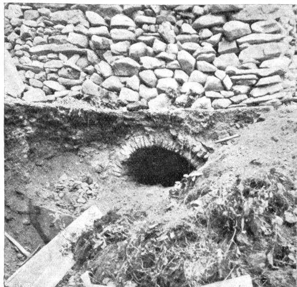
Husgrabungen in Difentis. Westliche Defining eines Gewölbes aus Kalksteinen.
