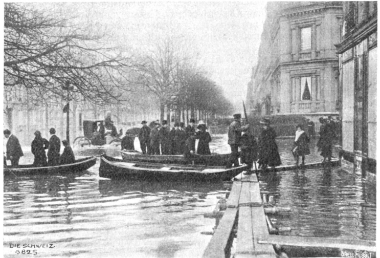
Die Uberschwemmung der Avenue Montaigne.
