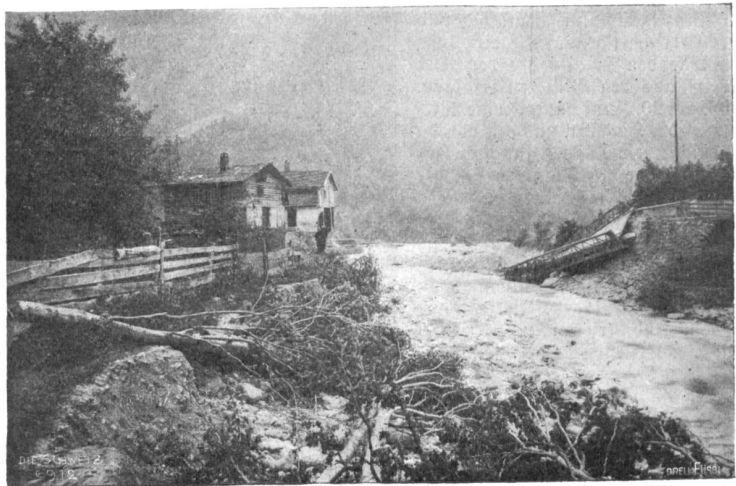
Straße und Bahnbrücke in Schjers. Phot. A. Graf, Davos.
