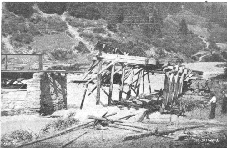
Dieselbe Brücke nach dem Einsturz. Phot. D. Mischol, Schiers.
