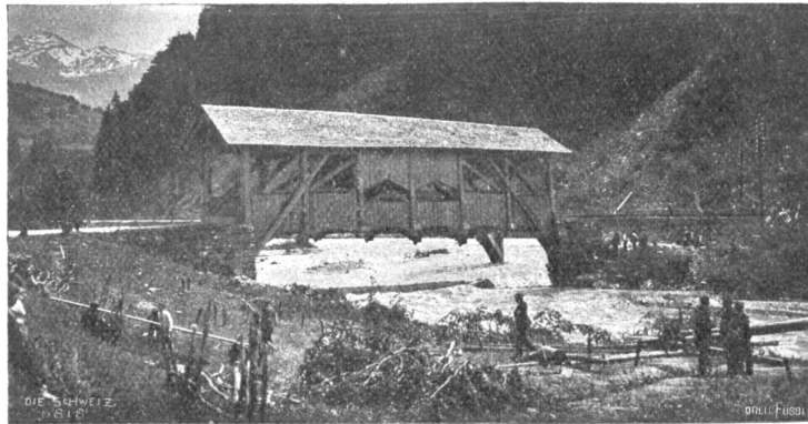
Brücke im Fuchswinkel zwischen Schiers und Jenaz vor dem Einsturz. Phot. D. Mischol, Schiers.
