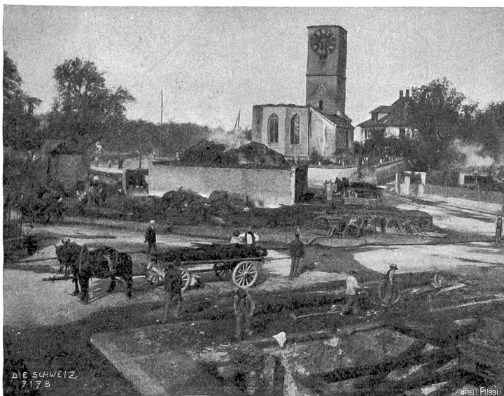
Die abgebrannte Kirche und der Dorfplatz von Hindelbank, Kt. Bern.
