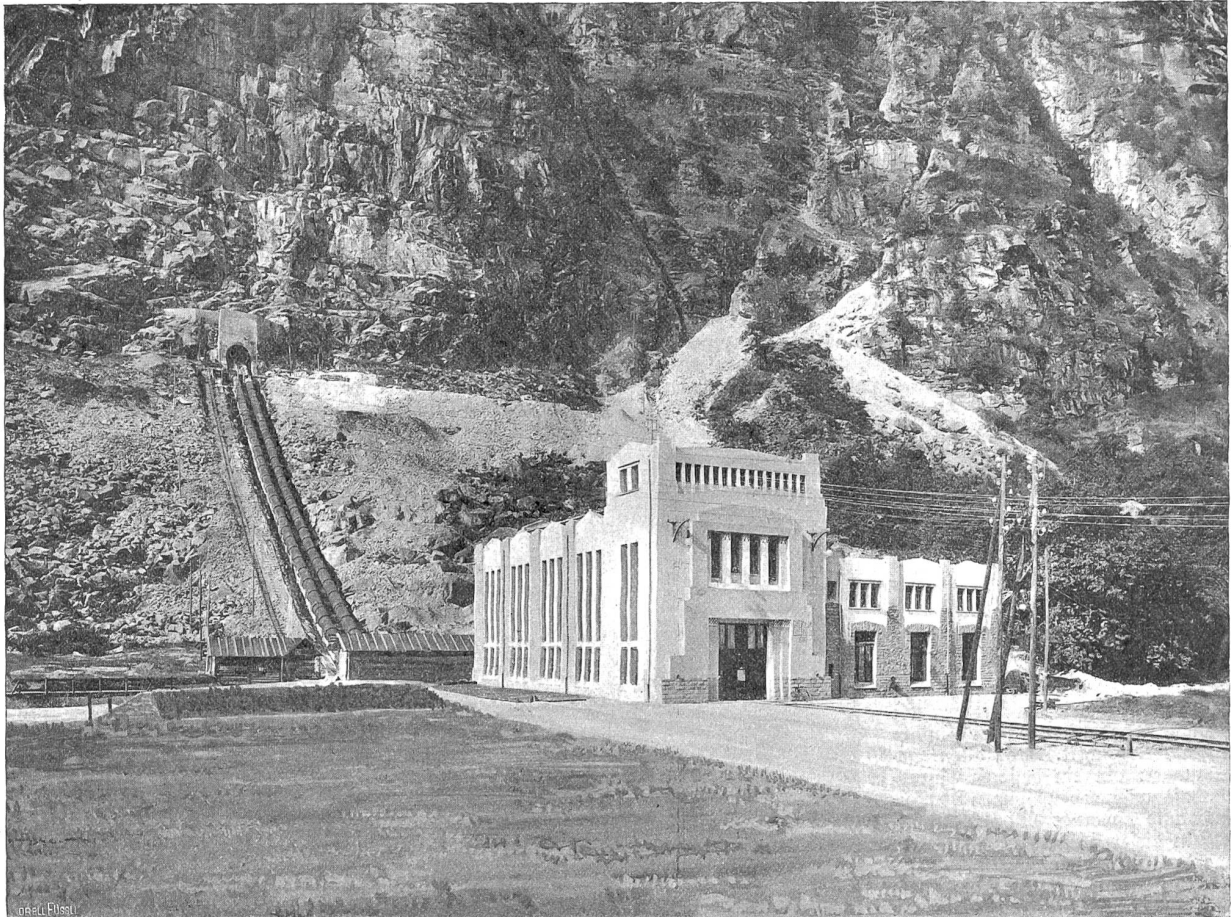
Das Kraftwerk Biaschina bei Bodio (Tessin).
