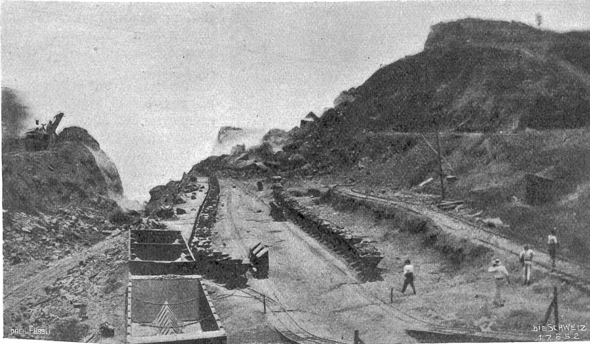
Vom Panama-Kanal Abb. 6. Bergkopf nach der Sprengung.
