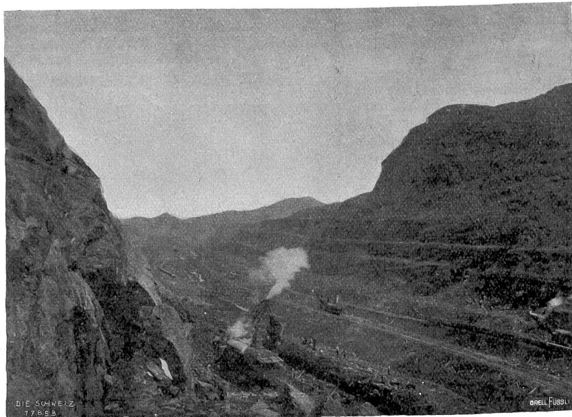
Vom Panama-Kanal Abb. 7. Culebra-Einschnitt; Dampfschaufel, die gebrochene Felsmaße auf Eisenbahnwagen ladend.
