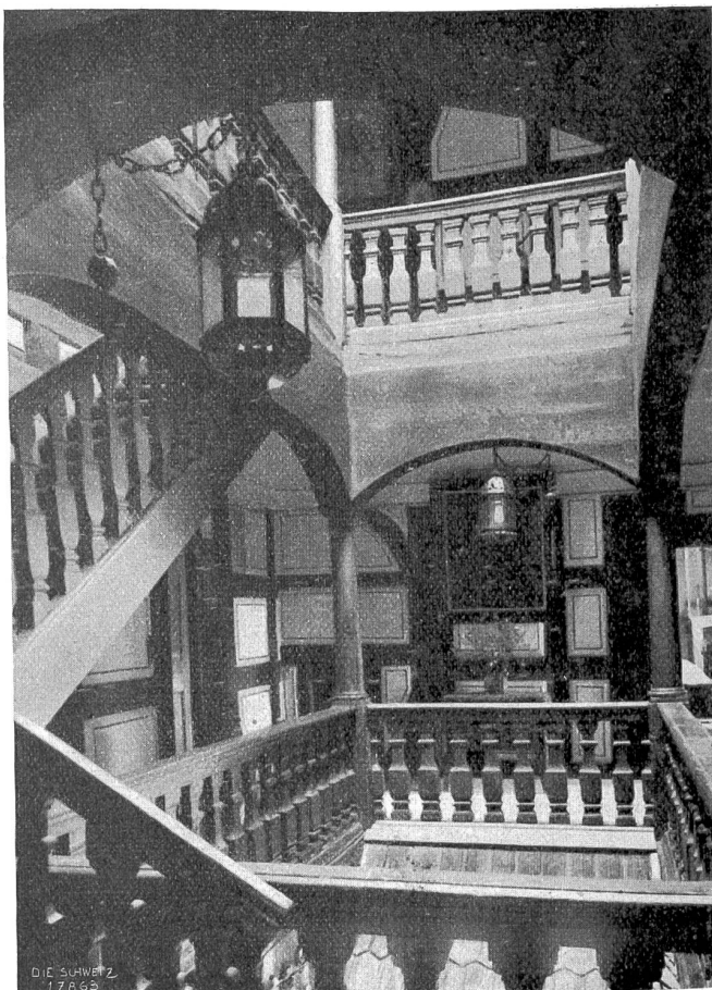
Hilt-Buonas. Obere Treppenhalle.
