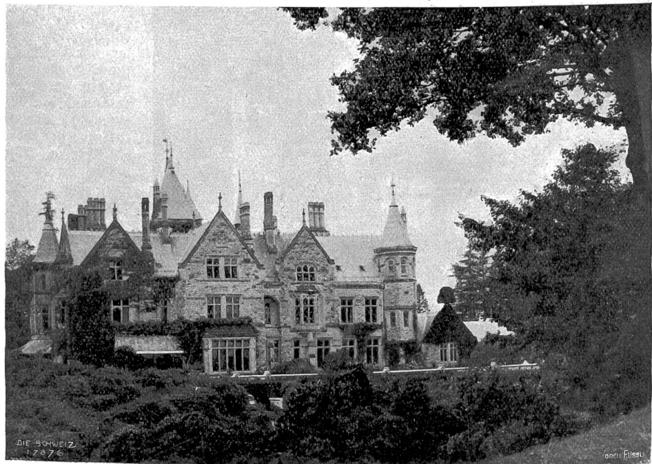
Neu-Buonas. Südfassade des 1870 erbauten „neuen“ Schlosses.
