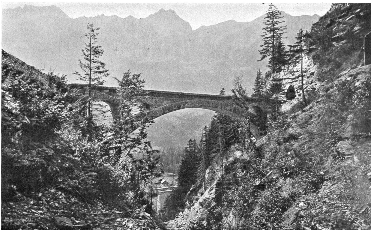
Lötschbergbahn: Brücke oberhalb Mittholz.
