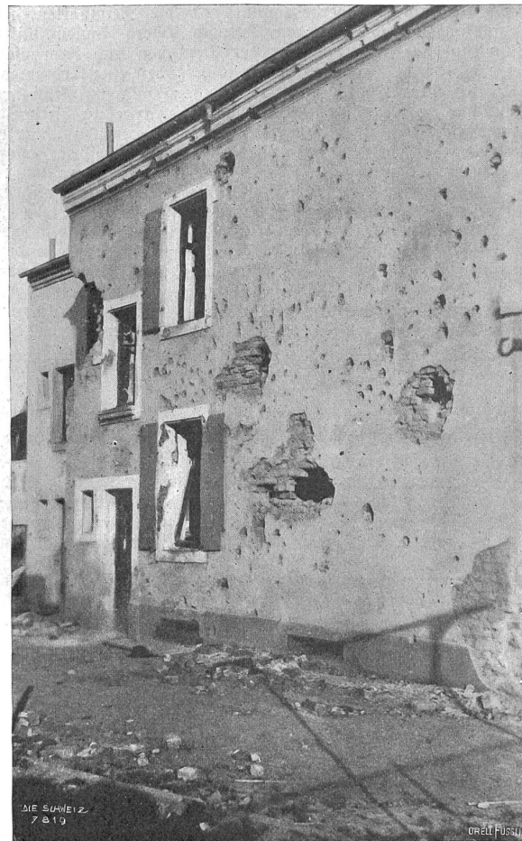
Durch Schrapnells und Flintenschüsse zerstörtes Haus in Illberg-Dornach (Elsass). Phot. Willy Schneider, Zürich.
