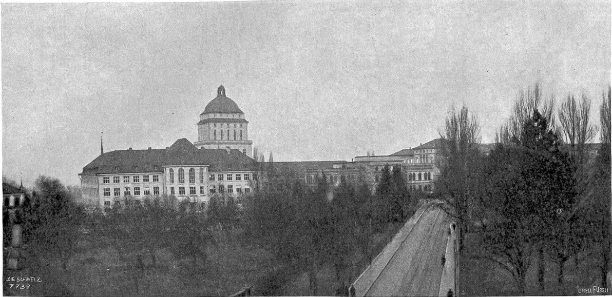
Die neue Zürcher Universität, von der Rämlistraße aus. Phot. B. Wiefe, Zürich.
