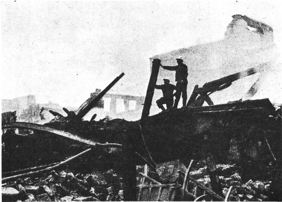
Fig. 11. — Incendie de la halle aux cuirs de Paris, 1906. Hennebique verse ce document au dossier de la combustibilité des structures métalliques.
