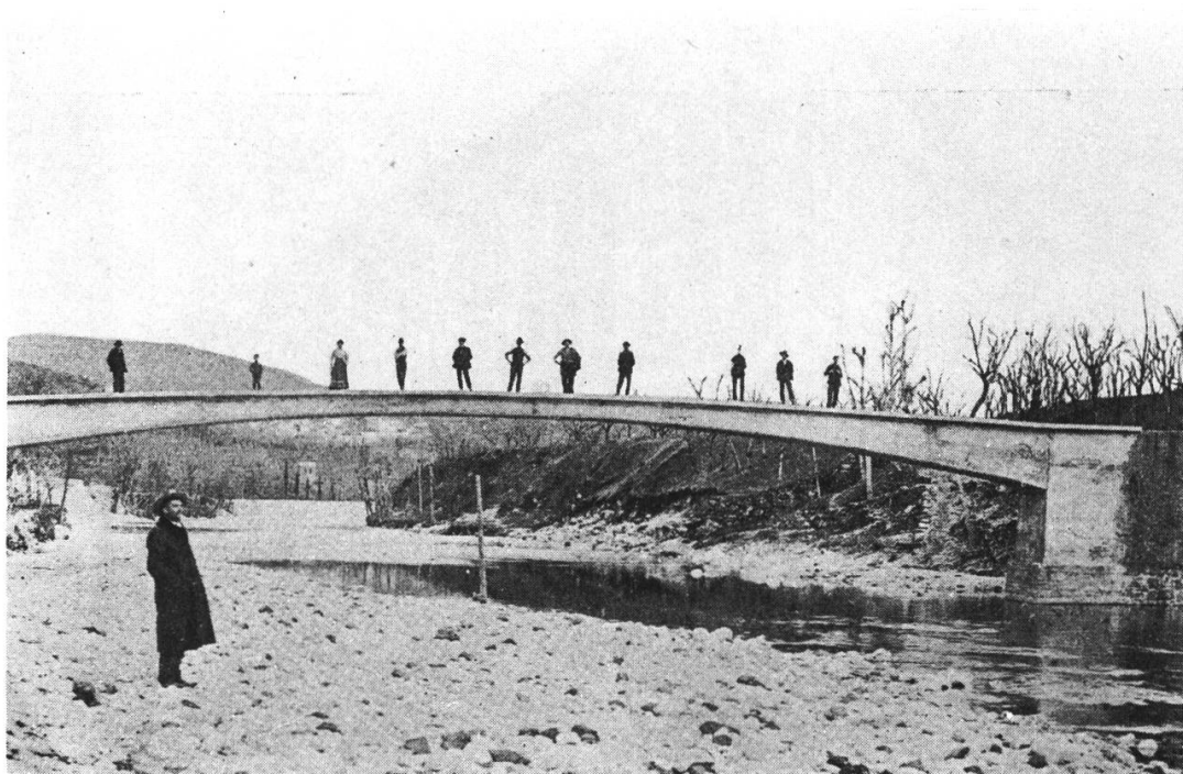
Fig. 19. — Pont routier sur l'Astico près de Calvene, en Italie, œuvre de l'ingénieur G. A. Porcheddu, agent turinois du brevet. Ouverture de 34 m 50. Photographie de l'inauguration, en 1908.
