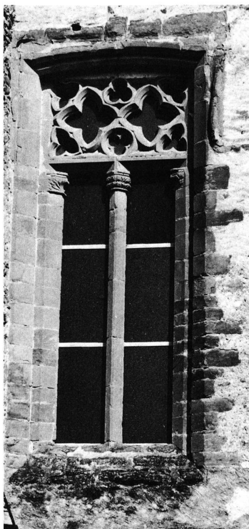
Fig. 7. Eglise de Contamines-sur-Arve: la baie sud-est (vers 1295-1300).
