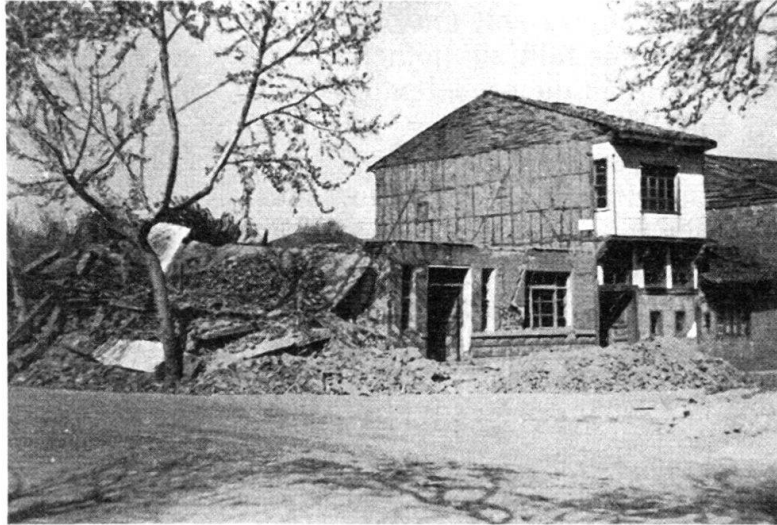
Fig. 4. Bild ungleicher Zerstörung in Gönen, links Backsteinhaus mit horizontalen Betonverstärkungen vollständig eingestürzt. Haus Mitte: zerstört, aber Backsteinmauern des Erdgeschosses stehengeblieben. Haus rechts: Holzriegelbau mit Lehmziegelfüllung, wenig beschädigt.
