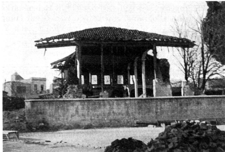
Fig. 5. Moschee in Gönen, schlechte Konstruktion.
