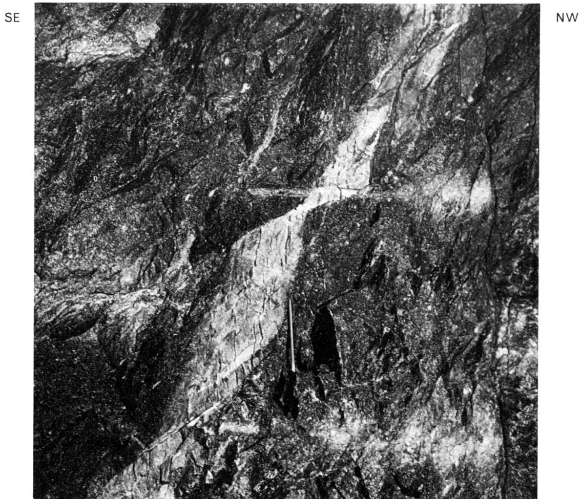
Fig. 9. An aplitischen Lagen im Innertkirchner-Granit sind die Überschiebungsflächen oft sehr viel besser zu sehen als im Nebengestein. Druckstollen Trift-Speicherberg, m 1501 ab Trift.
