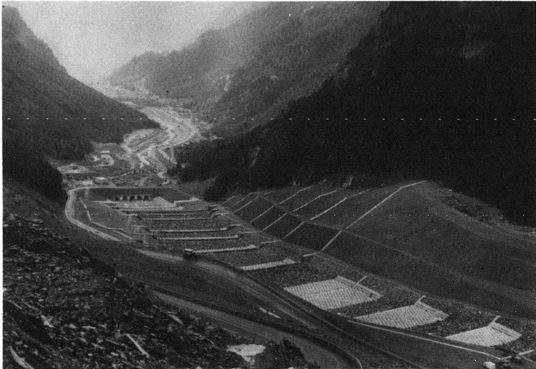
Fig. 14. Blick talabwärts. Der Bergsturzdamm (Fig. 9) wurde teilweise abgetragen und umgelagert. An seiner Stelle befindet sich eine grossangelegte Sperrentreppe. Der rechtseitige Damm ist zugleich Schutzwall gegen allfällige Nachstürze. Aufnahme: Juli 1990.
