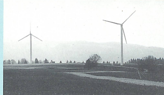
Dieser Windpark auf dem Mont Crosin bei St-Imier produziert 1,8 GWh Elektrizität – genug für 600 Haushalte.
