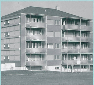
ZUM BEISPIEL: WOHNHAUS BRUGGHOF IN NIEDERURNEN Für die bessere Vermietung wichtig: 2/3 weniger Heizkosten
