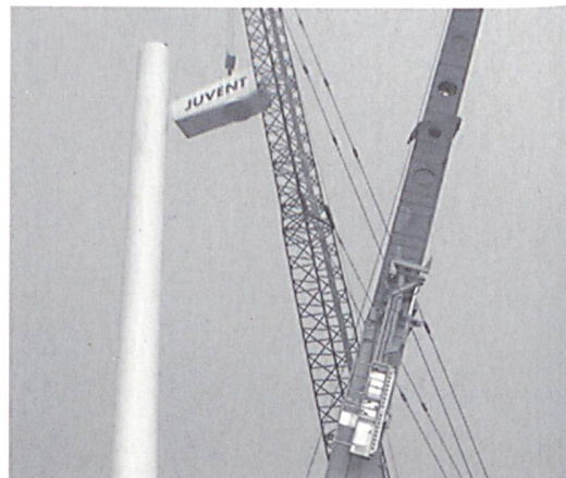
Mont-Crosin: Montage der zwei neuen Windturbinen
