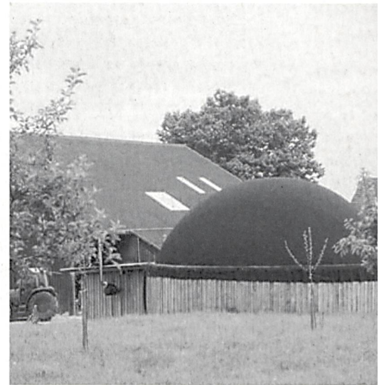
Biogasanlage in Goldach SG
