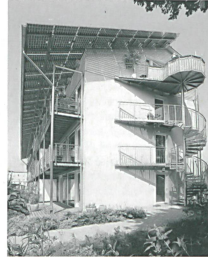
Eines von 50 Plusenergiehäusern der Solariedlung Schillerberg bei Freiburg (D).
