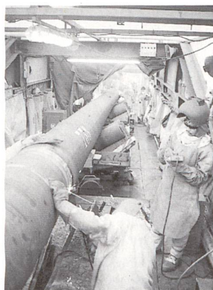
Construction de gazoduc.
