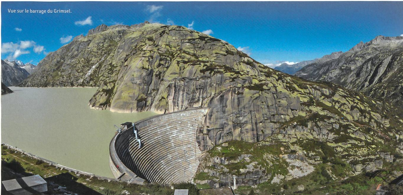
Pour produire de l'électricité, les quatre turbines de la centrale Grimsel 2 utilisent la hauteur de chute de 400 mètres entre l'Oberaarsee et le lac du Grimsel. Avec une puissance installée de 348 méga-watts, elles génèrent un bruit assourdissant, ce qui n'est pas étonnant, car jusqu'à 93 mètres cubes d'eau tonitruante déboulent chaque seconde sur les turbines. Grâce à un joint labyrinthe, les 50 bars de pression agissant sur les installations à pleine charge ne peuvent pas s'échapper.
