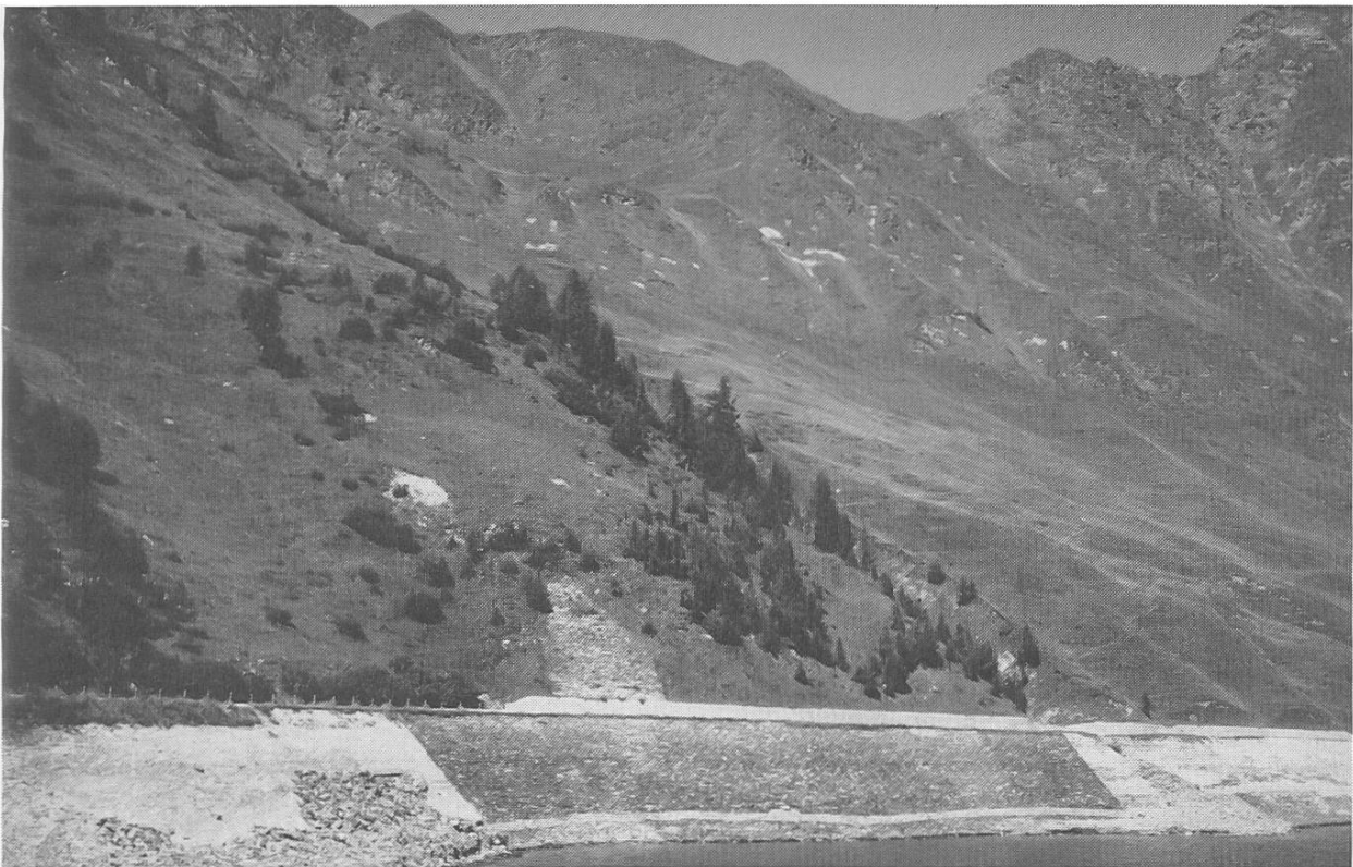
Abb. 18. Das Zentrum der idas -Population befindet sich im Lärchenbestand (Bildmitte). Im untern Bilddrittel folgt die Fahrstrasse mit 2 m hoher Stützmauer, darunter Seeuferpflasterung aus Steinblöcken und Seespiegel (im Jahr 1989 extrem tief).
