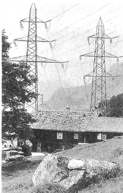
Der Urner Regierungsrat Ambros Gisler vertrat die Ansicht, dass 20 Meter Entfernung zu Hochspannungsleitungen genügen. Bauernhaus auf der Axenalp (Uri)
