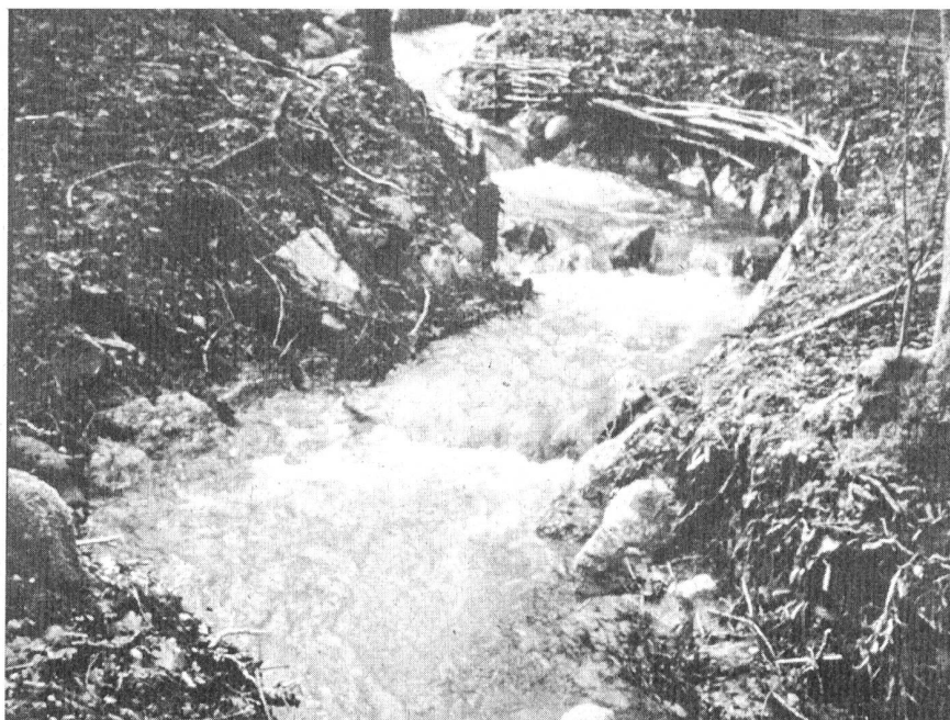
Umgebungsgewässer für den Aufstieg von Fischen und Kleinwassertiere.
