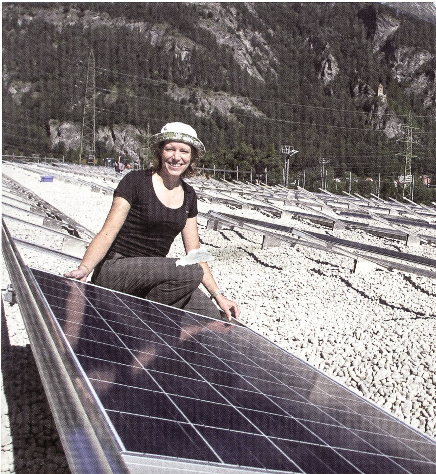
Sonja Lüthi hilft beim Bau der von der Genossenschaft Solar St.Gallen finanzierten Solaranlage auf dem Dach der Zentrale der Kraftwerke Zervreila in Rothenbrunnen mit.
