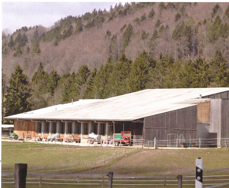
Auf diesem Dach könnte eine Photovoltaik-Anlage Strom für 100 Haushalte produzieren: Die Anlage ist möglicherweise ein Opfer der Photovoltaik-Bremse.
