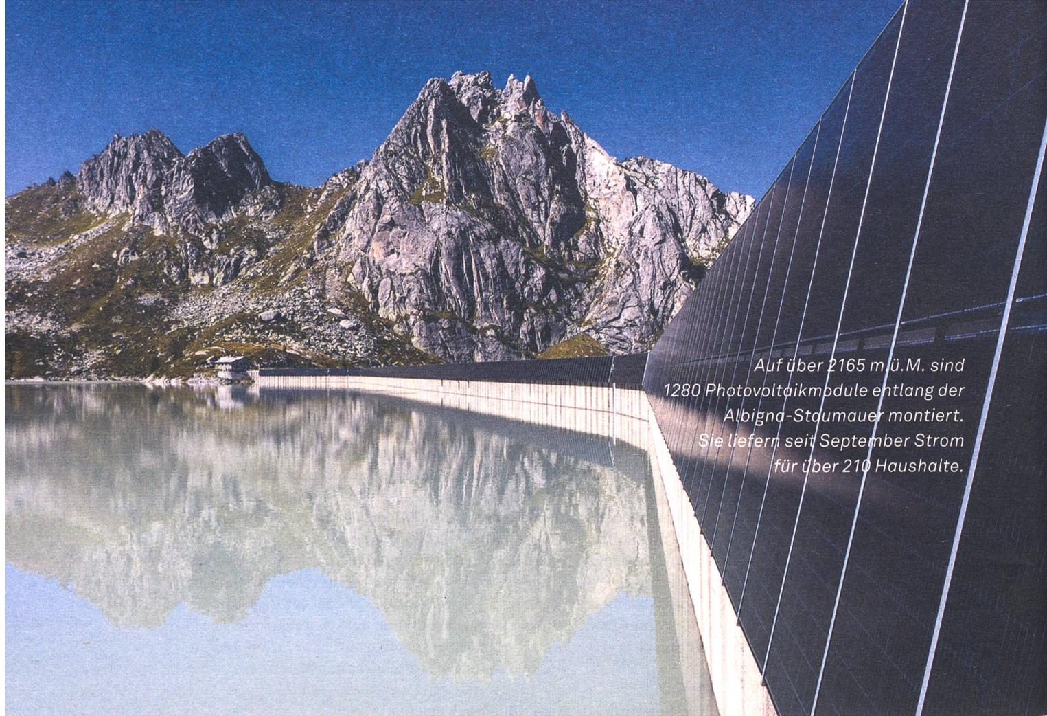
Auf über 2165 m ü.M. sind 1280 Photovoltaikmodule entlang der Albigna-Staumauer montiert. Sie liefern seit September Strom für über 210 Haushalte.
