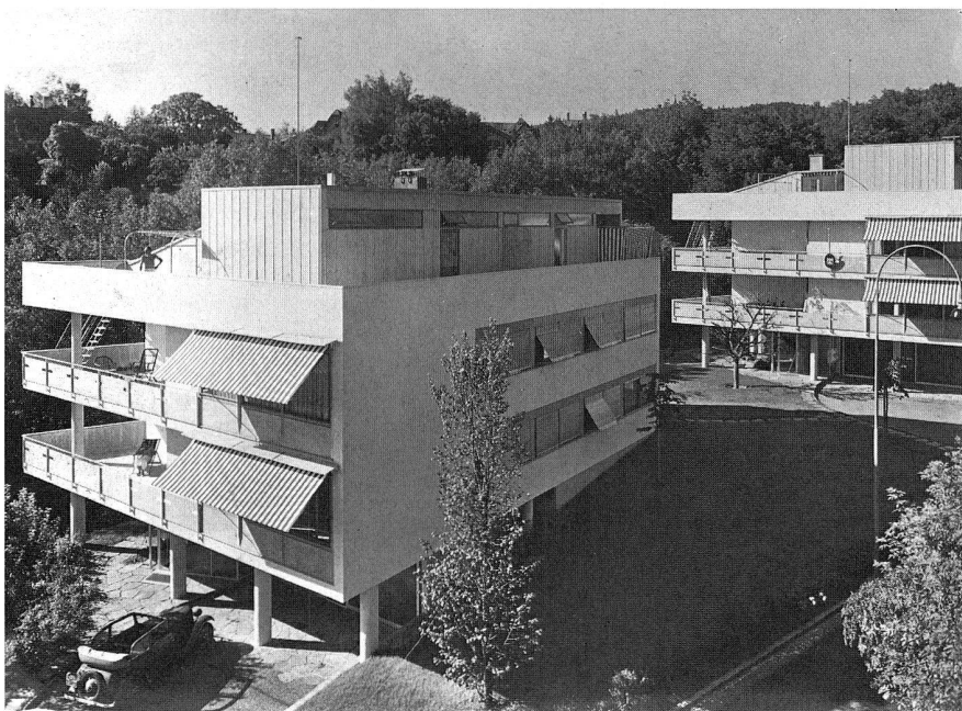
Die Wohnbauten «Doldertal». 1935/36.
