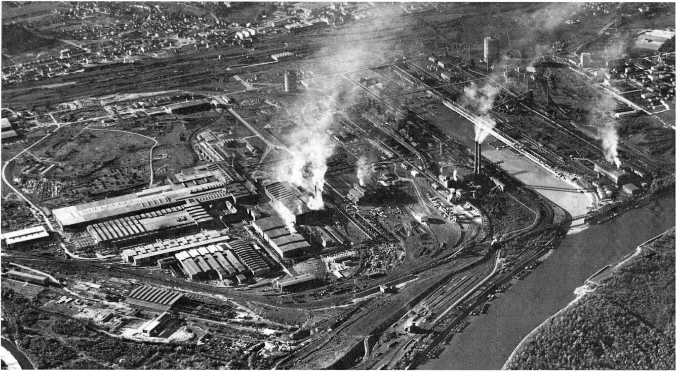
Bild 2: Gesamtansicht des Werkes Linz, um 1970. (Archiv der Stadt Linz, Abt. Dokumentation.)
