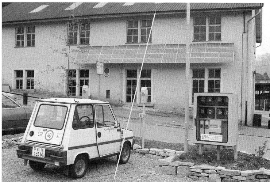
Solare Park + Ride-Anlage beim Bahnhof in Liestal.
