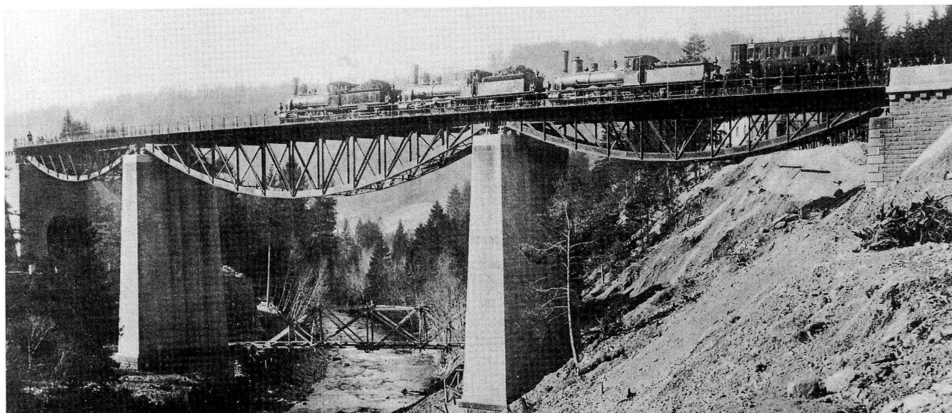
Wutachbrücke unter Belastungsprobe.
