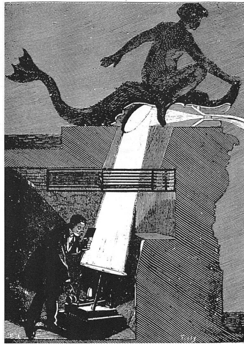
Fig. 5: Prinzip der Illumination von Wasserstrahlen mit elektrischem Licht an der Weltausstellung in Paris 1889.
