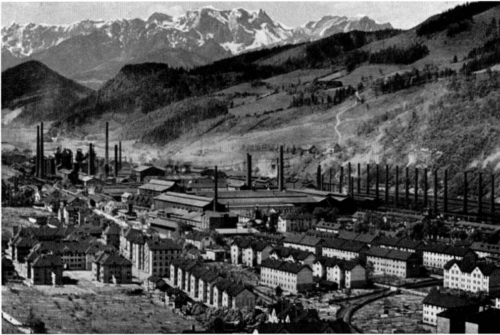
Das Werk Donawitz (Steiermark) der ÖMAG um 1930, Gesamtanlage von Süden. Die Schlotreihe rechts gehört zum Martin-Stahlwerk, in der Mitte das Feinwalzwerk, die Kraftzentrale, dahinter das Neue Blechwalzwerk, im Hintergrund links die Hochofenanlage. (aus: Kloepfer, Hans; Rihel, Hans: Das steirische Eisenbuch. Graz 1937, S. 49)
