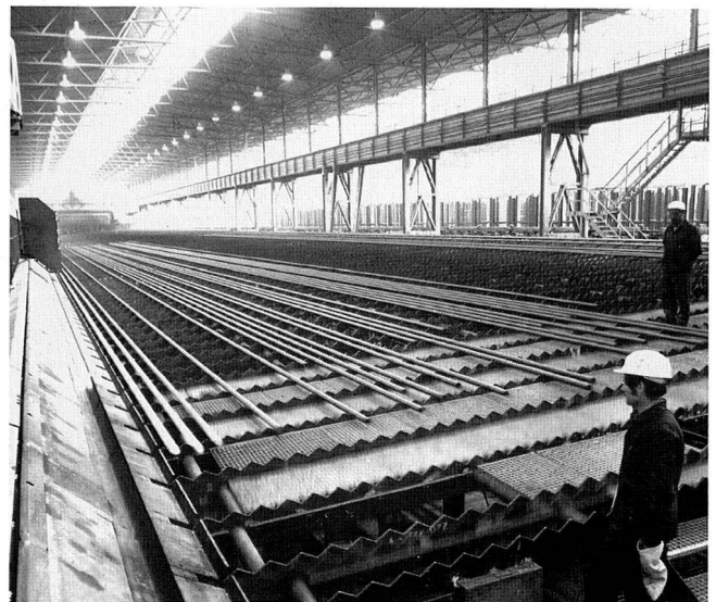
Bild 30: Kühlbett mit bis zu 160 m langen Rohren.
