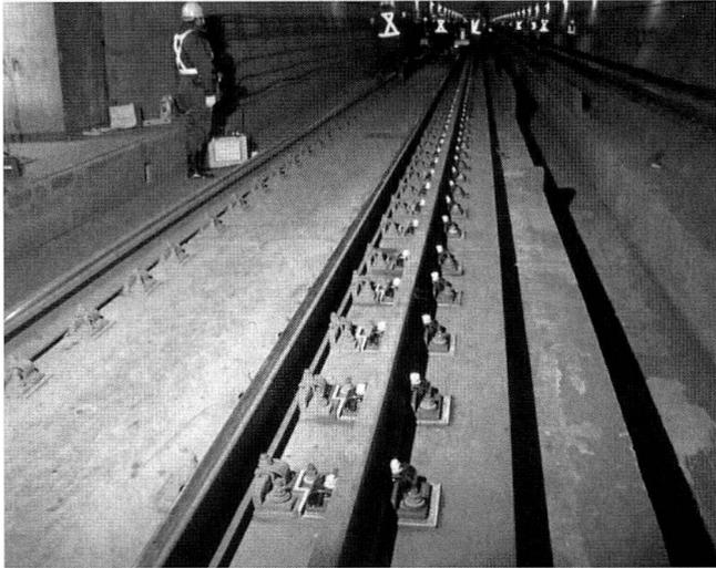
**Bild 3: Die feste Fahrbahn im Tunnel für die beiden Spurweiten «Kap» und «Normal». (Foto: JRTR)**
