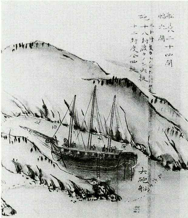
Bild 1: Der Bau eines Dreimasters nach westlichem Vorbild auf einer Schiffswerft in Satsuma, Süd-Japan, im Jahr 1857; Länge 43,68 m, Breite 10,92 m, mit sechs 18-Pfund-Geschützen und vier 12-Pfund-Geschützen (Quelle: Zeitgenössische Darstellung in einer Serie von 26 Bildern mit Text, gezeichnet von Senjū Dainosuke aus Saga, betitelt Satsu-shū mitori ezu; im Besitz der Präfekturbibliothek Saga).
