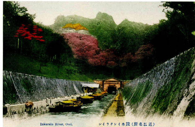
Bild 13: Wasserzuführung zum Kraftwerk Keage in Kyōto: Tunnelengang des Kanals auf der Seite des Biwa-Sees; Entwurf und Bau von Tanabe Sakurō, Absolvent des College of Engineering, fertiggestellt 1890. (Postkarte, Beginn des 20. Jh.)
