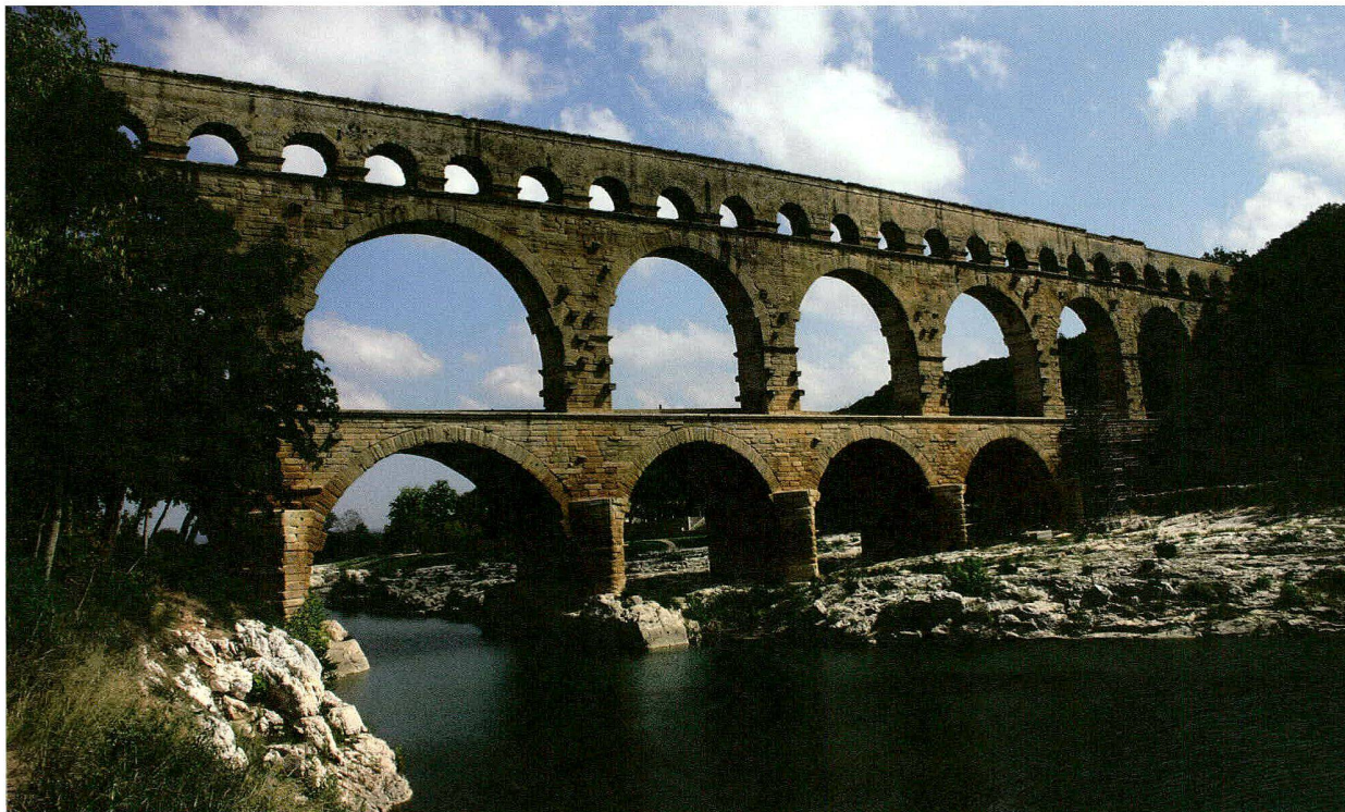
Aquäduktbrücke Pont du Gard – eines der Glanzstücke im römischen Wasserleitungsbau.
