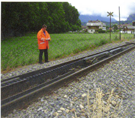
Moderne Zahnstangeneinfahrt für Riggenbach-Zahnstange.
