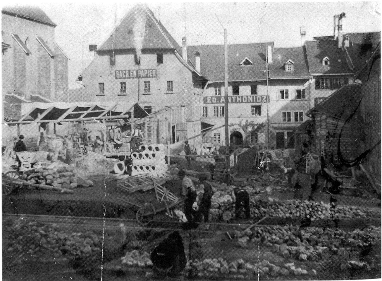
Abb. 7: Bauarbeiten am Tramdepot (heute als Burggarage bekannt) zwischen Franziskaner- und Liebfrauenkirche, 1900.
