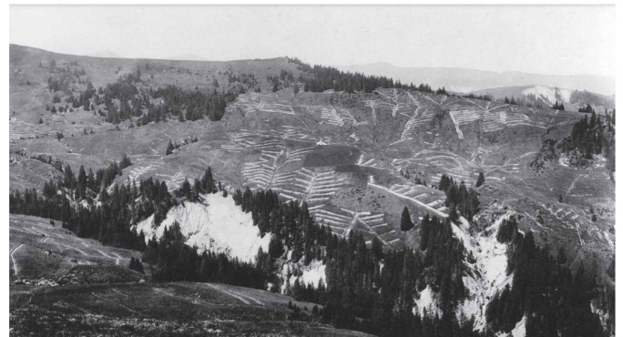
FIGURE 4.16 – Höllbach (Singine), fin du XIXe siècle. Toute la vallée a été drainée en vue de la reboiser. Source inconnue.
