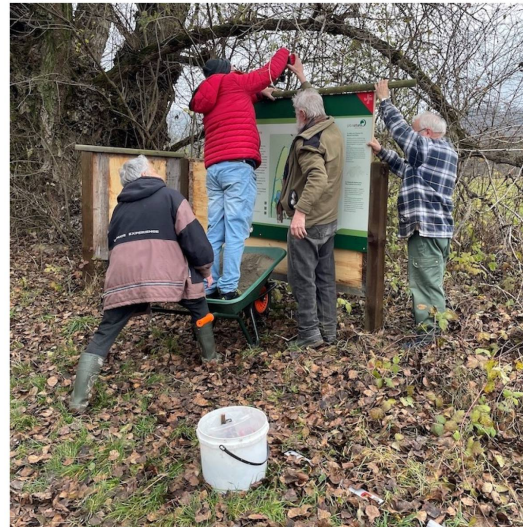
Installation einer neuen Informations-tafel im Naturschutzgebiet Auried © Emanuel Egger
