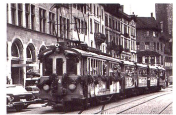
Letztes Schleithheimer Tram StSS, 1966
