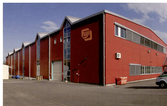
Im «roten Haus» in Dielsdorf ist die Verwaltung von Chromos AG und Fujifilm (Switzerland) AG sowie das Produktlager von Fujifilm untergebracht.
