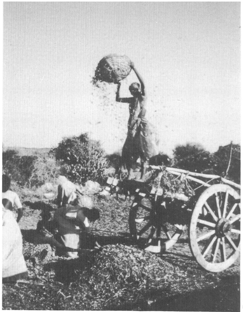
Erdbauberin in Andhra Pradesh, Indien Foto von Helen Zweifel
