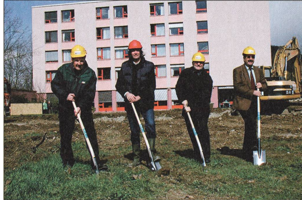
Spatenstich für die Alterswohnungen hinter dem Alterszentrum Bruggbach mit v.l.n.r. Vereinspräsident Dieter Deiss, Architekt Norbert Walker, Gemeindeammann Anton Mösch und Geschäftsführer Robert Jäggi.
